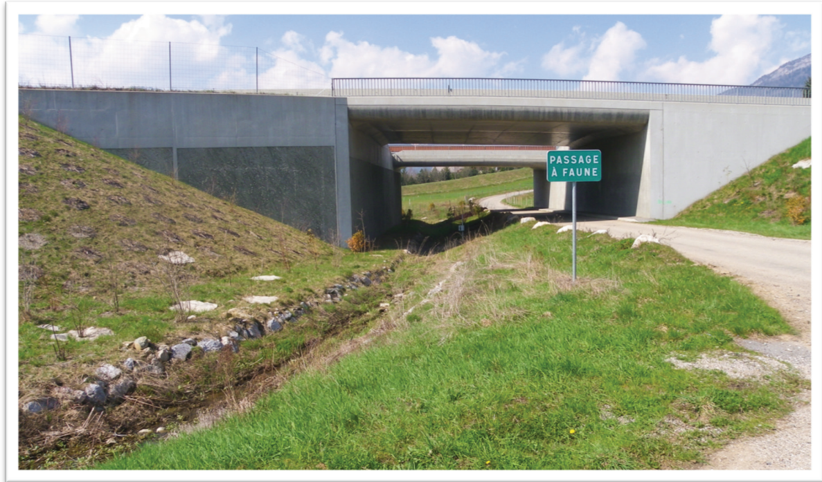
Figure n°12 - Passage à faune des Cadorats (38) – A51 15
